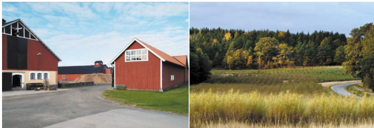
När Svartsjö tvångsarbetsanstalt övertog arrendet av kungsgården 1909 uppfördes nya ekonomibyggnader i anstaltens närhet. Byggnadernas arkitektur bevaras exteriört men de har anpassats för nya funktioner. Mellan byggnaderna ligger en hög med flis till värmepannan. Till höger. Svartsjö kungsgård klarar större delen av anstaltens energiförsörjning från egen odling av energiskog.
