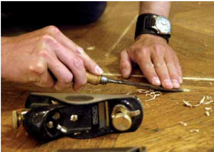
Skruvarna i de gamla spikhålen döljs av träpluggar som jämnas av och färgas in med parketten.
