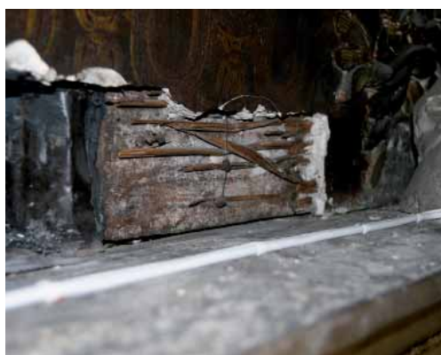
Taket är uppbyggt av brädpanel på ett regelverk av trä. På panelen har vass fästs med spik och metalltråd som underlag för gipsen.
