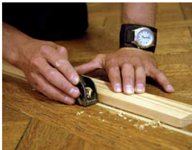
På vissa tavlor har man lagt in tunna lister där glipor uppstått i parketten. Listerna hyvlas plana med golvet och färgas sedan in med pigment och olja för att bli så osynliga som möjligt.
