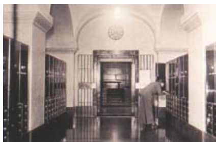
Ovanifrån: Bokföringsavdelningen på plan 6 kunde liknas vid ett modernt kontorslandskap. Spar- och kupongkassan med kalksten på golv, väggar och disk. Depositionsvalvet i betong.
