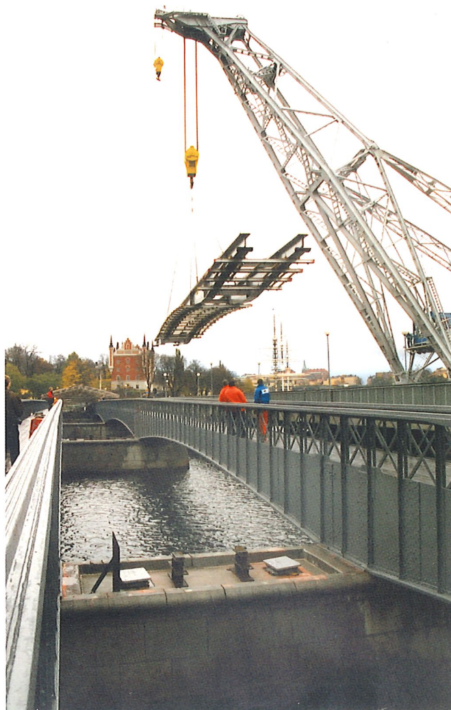
Den nya körbanan till Skeppsholmsbron lyfts på plats av Stockholms hamns pontonkran Ragnar Lodbrok.
