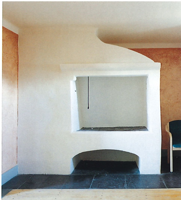
Vid renoveringen på 1930-talet revs alla eldstäder ut med undantag för en öppen murad kölesspis fem trappor upp.
