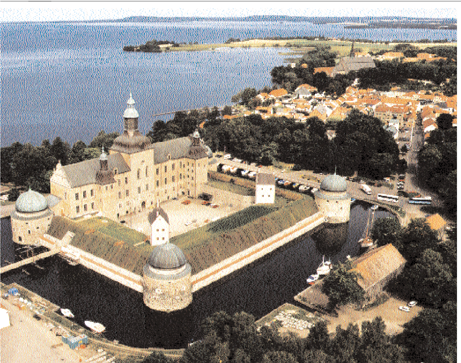
Visionen har blivit verklighet. Den återuppförda slottsvallen knyter samman slottsanläggningens delar till en arkitektonisk och rumslig helhet.
