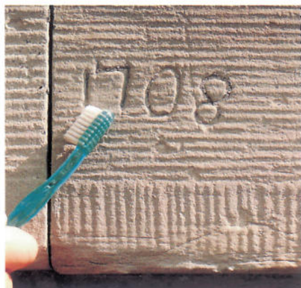
På hörnet mot Storkyrkan finns en ristning, cirka en och en halv meter upp på fasaden som visar hur högt längan murats 1708.
