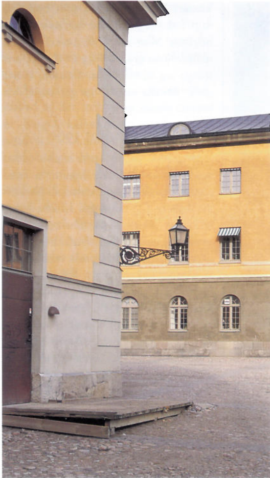
Livgardets kaserner inrymmer idag Riksantikvarieämbetet. Huvudbyggnaden fick sin pigmentstarka färg av Sigurd Curman vid ombyggnaden under andra världskriget. Den har sedan förnyats. Västra flygeln, till vänster i bilden, fick vid fasadrenovering härom året en färgsättning i något ljusare gult och grått, mer typisk för klassicismen men ändå med hänsyn till huvudbyggnaden.
