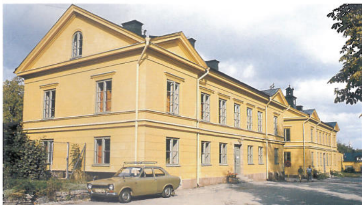
Den djupt gula färgen på Skeppsholmens byggnader har inte så gammal hävd som vi vant oss att tro. Bilden visar kanslihusen vid varvsentrén på 1970-talet. I dag har husen återfått sin äldre ljusgrå färgsättning.
