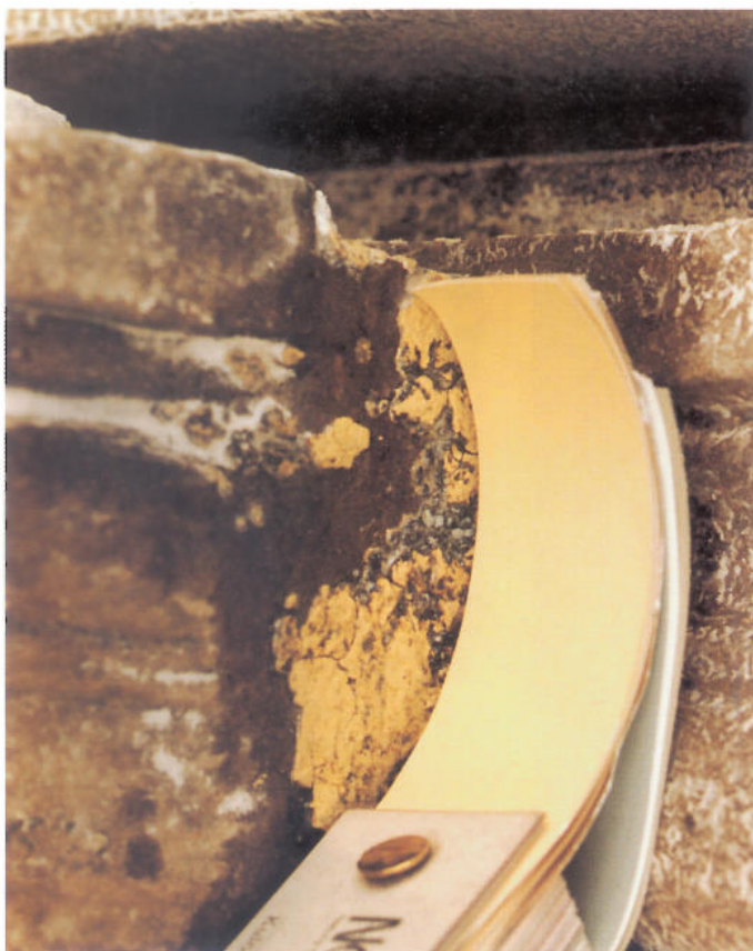
I fönsteromfattningarnas vinklar finns ofta tydliga spår av oljefärg. Då slottet stod färdigt målades allt stenarbete i samma ljusa gula färgton som de putsade fasaderna.
