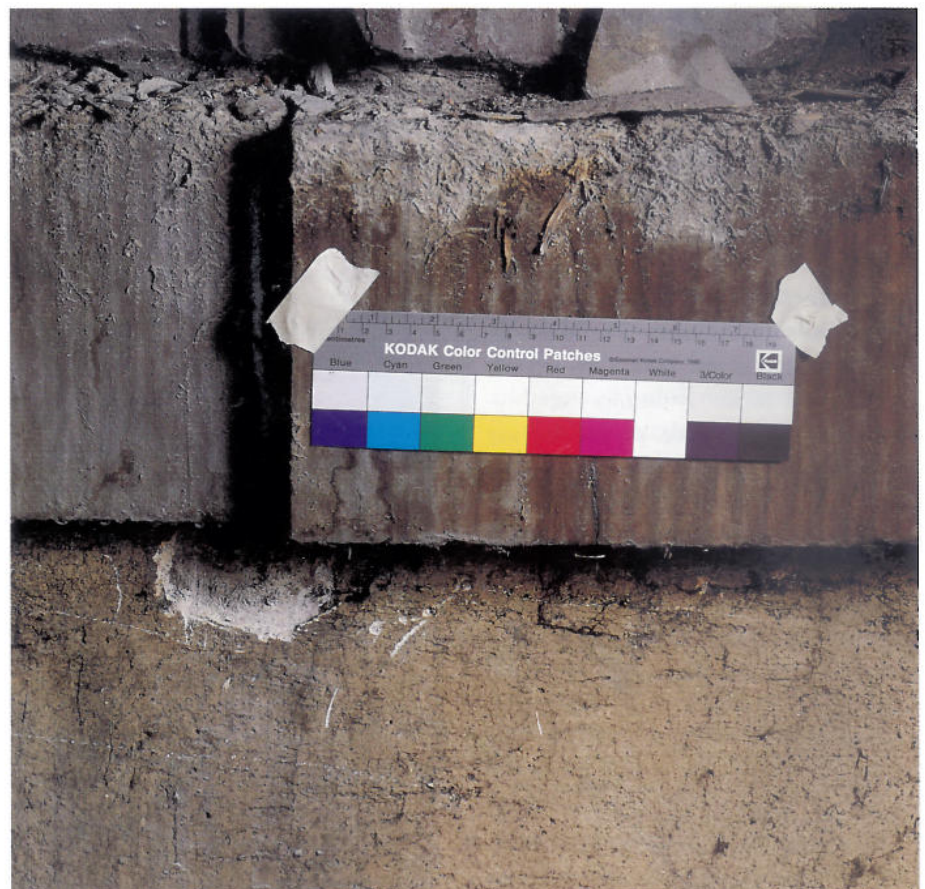
På Kungliga husgerådskammarens vind finns puts och målade sandsten som visar att västra fasaden var monokromt ljusgul vid tiden för nordvästra flygelns tillkomst 1757–60. Oljefärgen på fönsteromfattningen har mörknat och blivit brun där linoljan anrikats.
