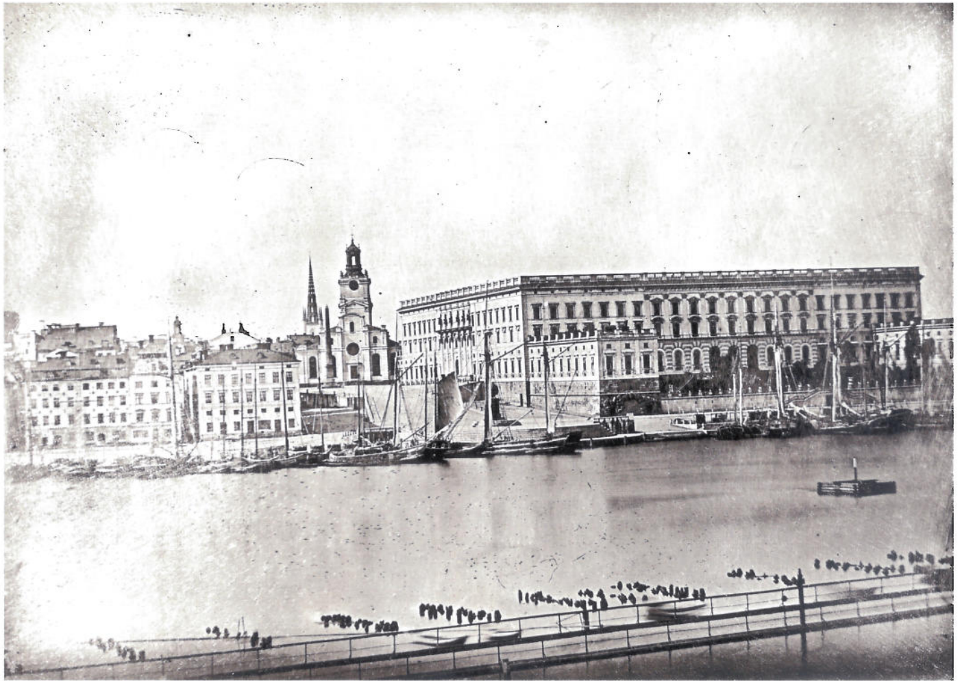
På en unik daguerrotypi från 1840-talet ser vi slottet som det såg ut strax efter att Karl Johantidens stora renovering var avslutad. Vid Logårdska kajan trängs fortfarande ännu skutor och segeljakter och än dröjer det något år innan ångbåtsröken ska börja svärta fasaderna. I förgrunden syns resterna av den gamla Skeppsholmsbron som förstördes av eld 1822 och den provisoriska pontonbron som utgjorde ersättning fram till dess den nuvarande bron stod färdig 1862.
