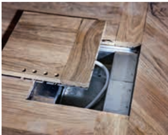
Inga av de moderna installationerna ska synas. Under golven ligger kablar för el, bredband och styrning av husets tekniska funktioner.
