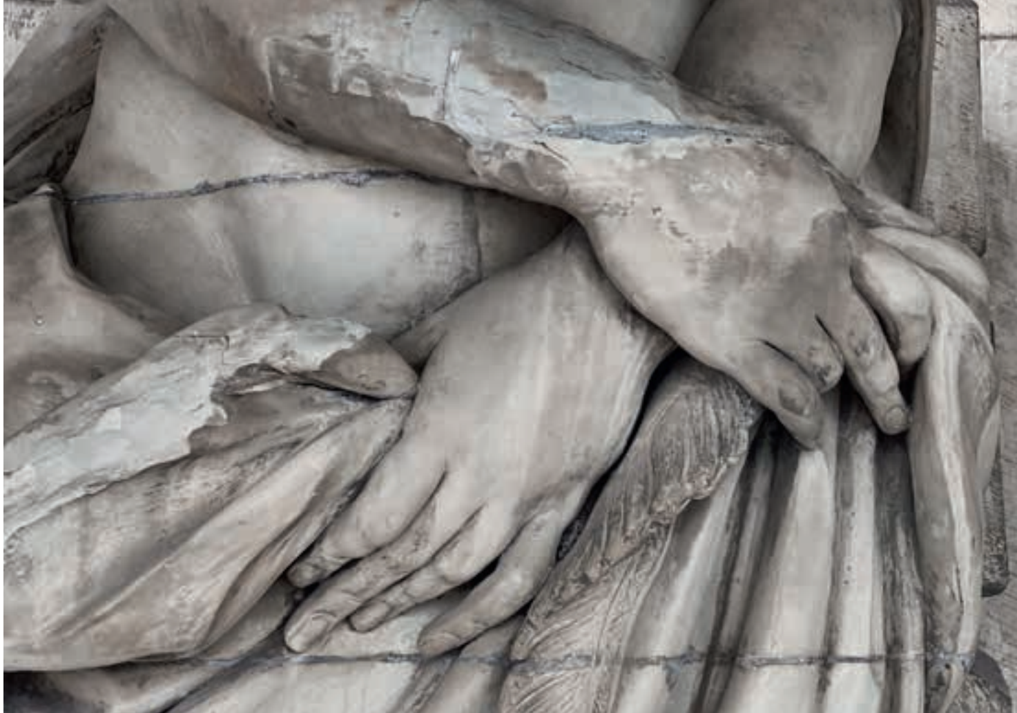
Graciösa, vackert utsnidade händer håller om klädstycket. Trots runt 260 år på nacken är karyatiderna väldigt fint bevarade. Men stenen vittrar allt snabbare och de skavanker som finns ska åtgärdas med stenlagningsbruk.
