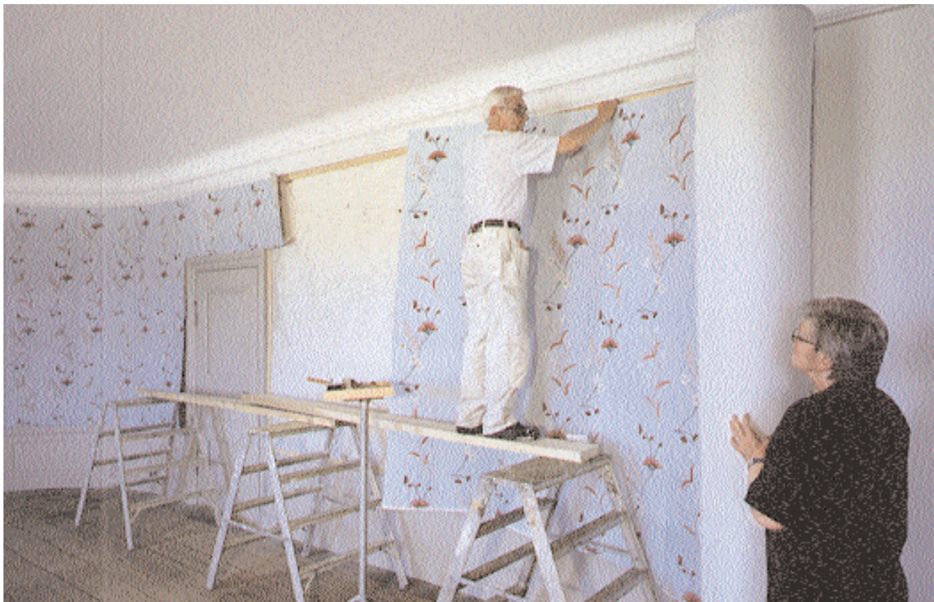
Det stora tapetsjoket står ihoprullat på en tapetvagn och förs försiktigt ut på väggen och fästs med nubbs utmed taklister och foder.
