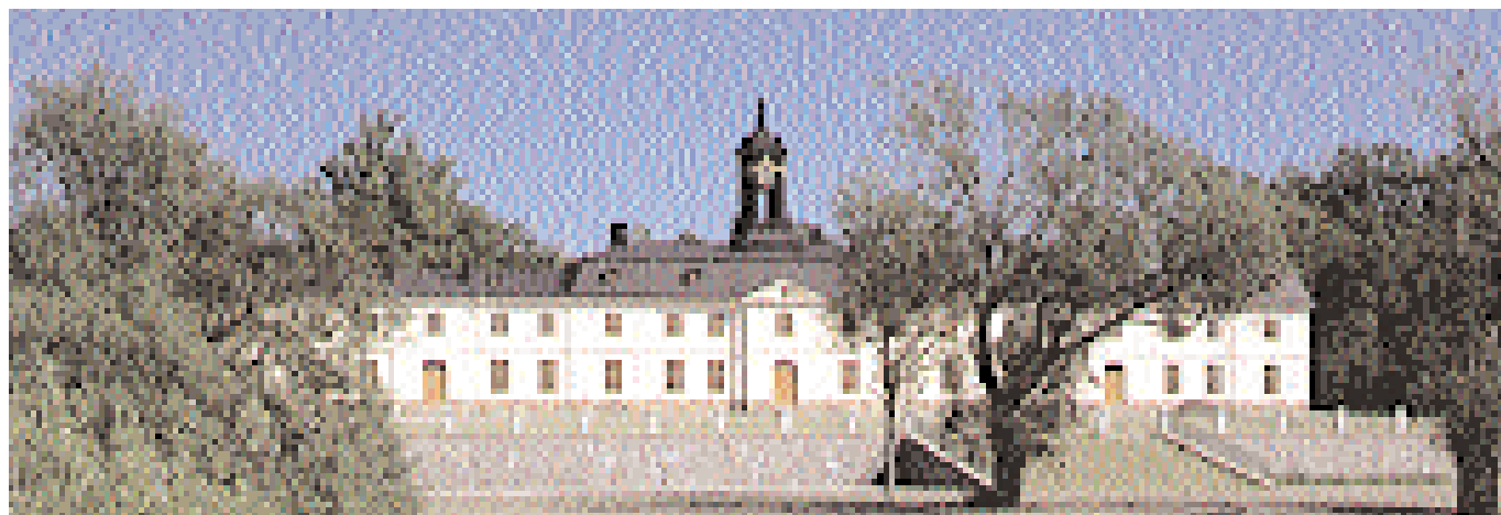
Svartsjö slott på Färingsö har återfått sin ljusa 1700-talsfasad med ockrafärgade snickerier. Mot sjösidan har terrassmuren med sitt räcke av smidesjärn återuppstått och nu är även interiören färdigrenoverad.
