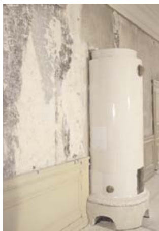
Följ renoveringsarbetet på www.sfv.se
