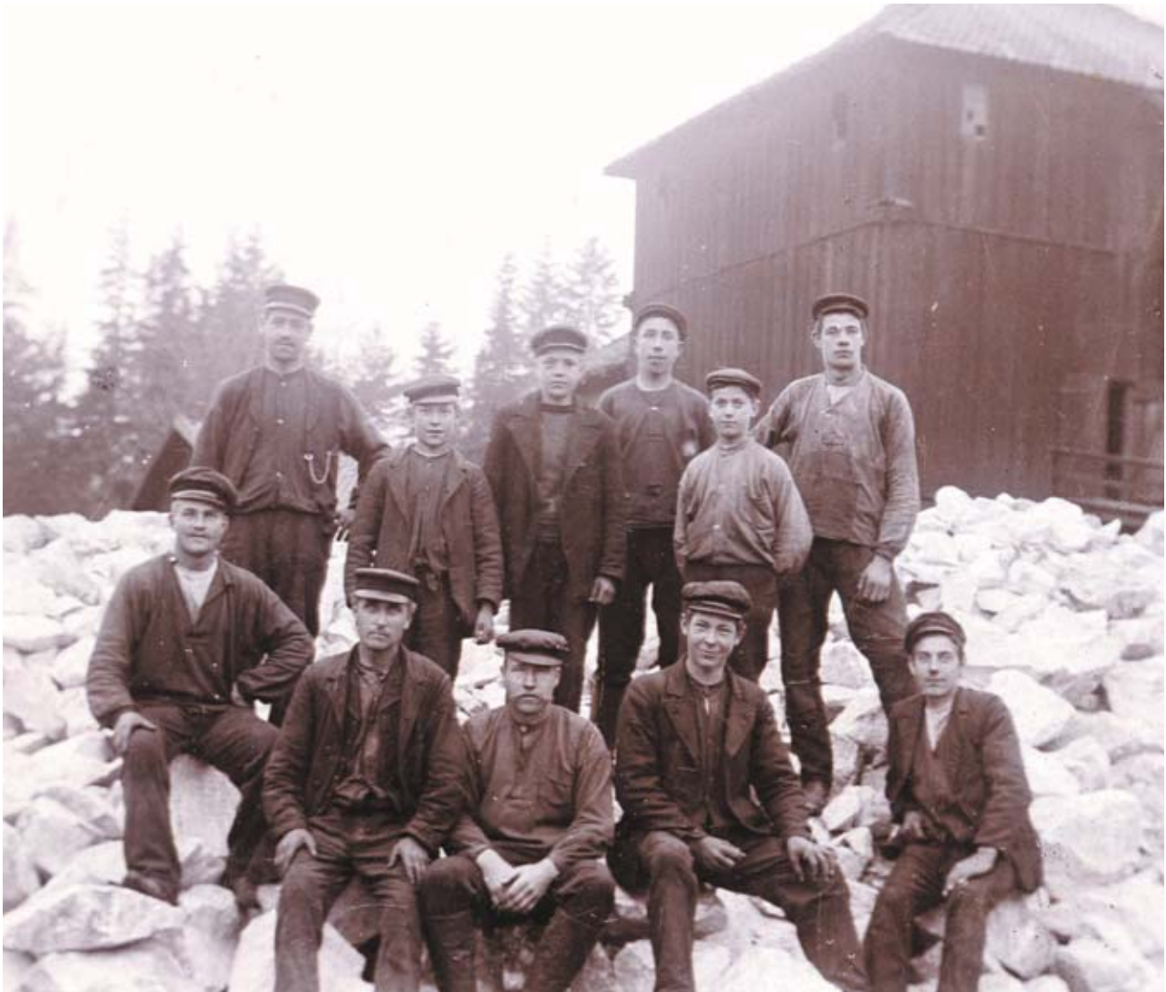
Arbetslaget vid hyttan uppställt till fotografering på kalkstenslagret vid förra sekelskiftet. Arbetet bedrevs intensivt den tid ugnen var igång. Åtta timmars arbete följdes av åtta timmars vila och så arbete igen. Så fortgick det dygnet runt, vecka efter vecka och månad efter månad, ibland upp till elva månader i ett sträck.
