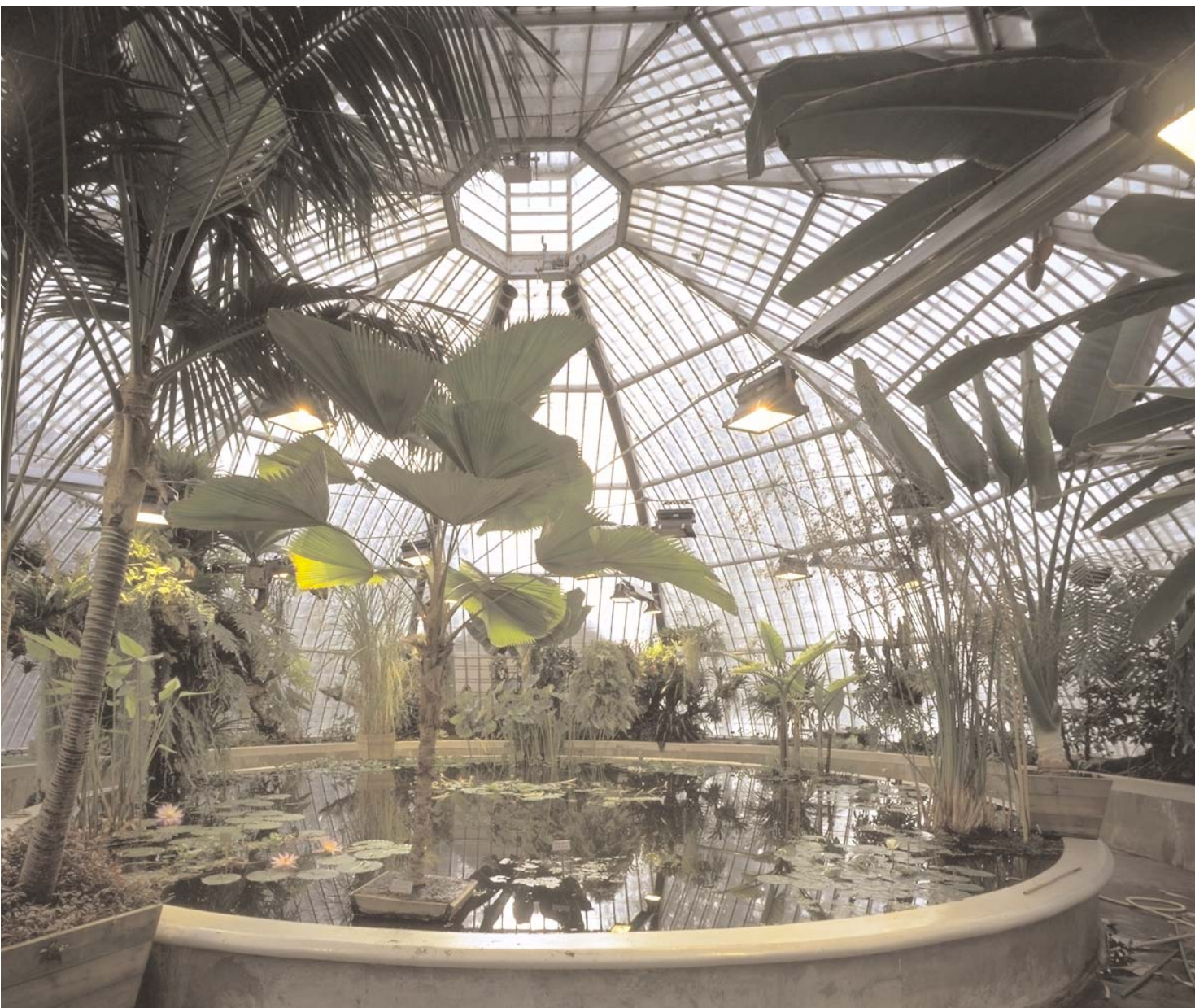
Victoriaväxthuset tillverkades i Tyskland och transporterades till Sverige för hopsättning och montering. Liknande växthus med stålstomme uppfördes vid förra sekelskiftet på flera håll runt om i Europa.
