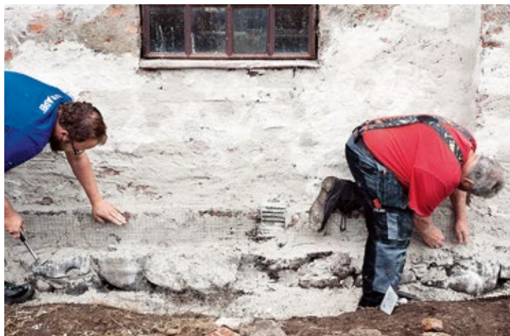
Efter grundningen spikades putsnät upp på fasaden och därefter spritsades väggen. Karl-Johan Olsson och Evald Jon Strøm samarbetar.
