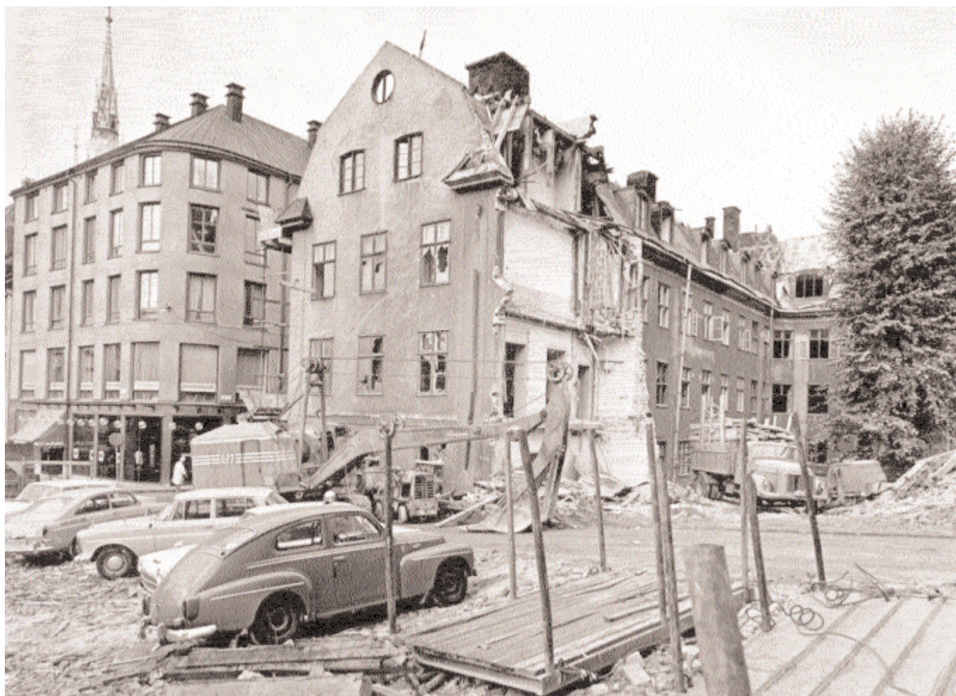
En del av kullen vid Haga består av rivningsmassor från skövlingen av Norrmalm på 1960-talet. Den mest anmärkningsvärda rivningen över huvud taget i samband med rivningsvägen inleddes i augusti 1968, då Preissiska huset på Drottninggatan 36 angreps av grävskoporna. Fastigheten var skyddad som statligt byggnadsminne fram till 1/7 1968, då ett markbytesavtal mellan staten och staden trädde i kraft och medgav att fastigheten fick rivas. Den äldsta delen visade sig vid rivningen ha ett målat bjälktak som kunde dateras till 1600-talets mitt.
