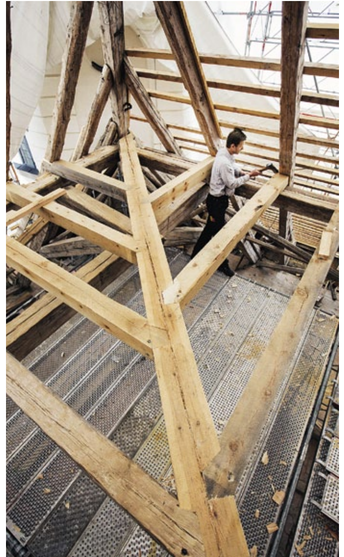
Diagonal hanbjälke mellan yttre och inre gradsparren, med respektive takfalls hanbjälkar som möter i 45 grader. Mattias justerar i en knut.
