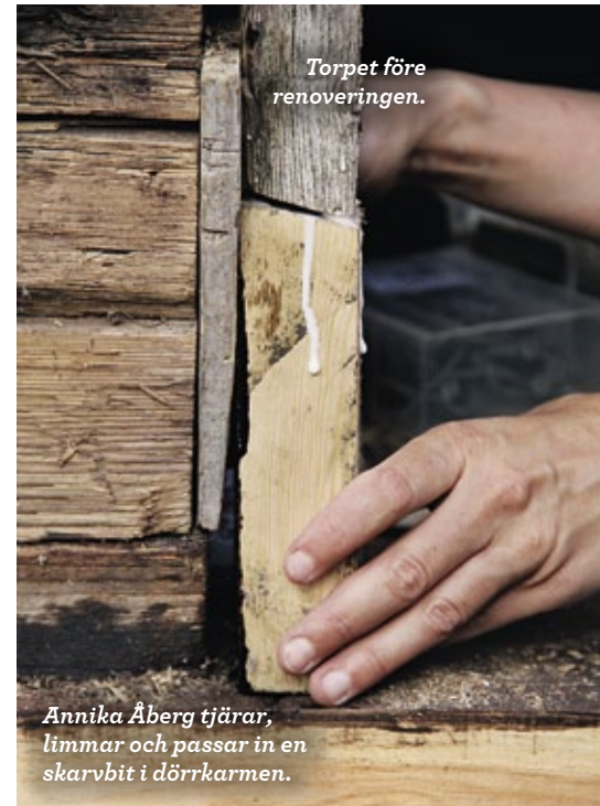
Med nymålade fönster, ny Falu rödfärg på fasaden och nyrenoverad dörr står Hökaryd bättre rustat för väder och vind. När taket väl är lagat kommer torpet att vara rustat för många år framöver.
