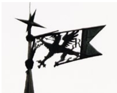
Den gamla flöjeln från början av 1700-talet var tillverkad i hamrad kopparplåt. Det första hantverkarna fick göra var att försiktigt veckla ut den gamla Gripen för att sedan kunna kopiera den. Originalet ritades av, digitaliserades och skars därefter ut med vattenjet-teknik.
