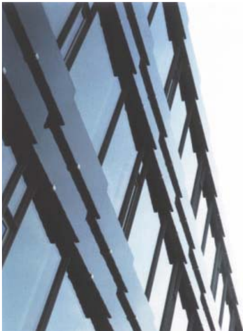
Mot väster är fasaden klädd med blankpolerad svart emmabodagranit. Stenarna är lagda omlott och burna i balans av rostfria hakar.
