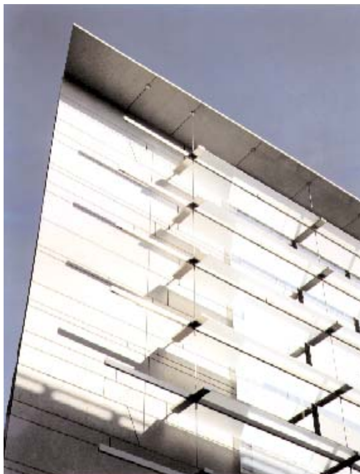
Mot söder är fasaden utförd i vit grovslipad gotlandskalksten. Stenen har vinklats ut till fond för de hängande solskyddsglasen.
